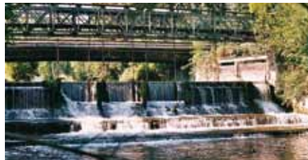
Brücke über die Murg
